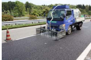
写真-2 分解材の散布状況
