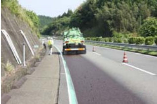
写真-1 浸透型補修材の散布状況
