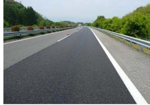
写真-3 施工完了
