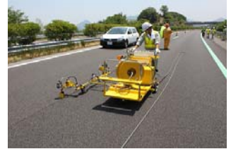
写真-4 舗装縦継目への浸透型補修材注入状況
