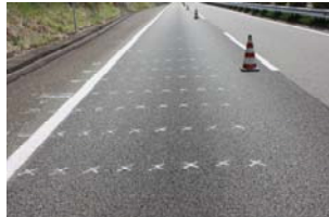
写真-5 散布直後（散布工区）
