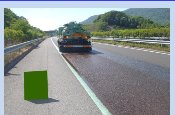
浸透型舗装補修材散布 (標準散布量2.1 ℓ/m³)
