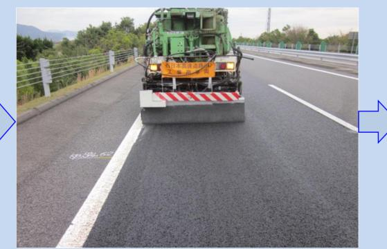
分解材散布 (標準散布量0.5 l/m²)
